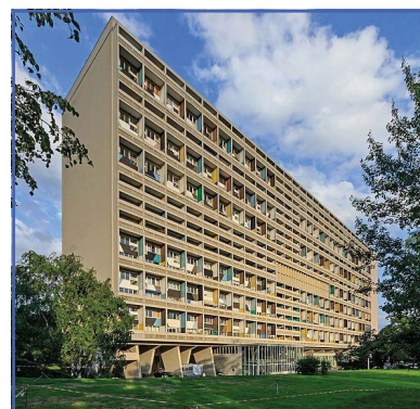
UNITÉ D'HABITATION, MARSIGLIA (1947-52). LE CORBUSIER IN QUESTO COMPLESSO RESIDENZIALE, CHE OSPITA 337 ALLOGGI, HA SPERIMENTATO A Scala EDILIZIA IL CONCETTO DI MACHINE À HABITER.
