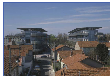
COMPLESSO RESIDENZIALE SPERIMENTALE "NEMAUSUS" PER 114 ALLOGGI E SERVIZI, NÎMES (1985-87). JEAN NOUVEL PROPONE UNA DELLE POCHE ORIGINALI RIFLESSIONI SULL'ALLOGGIO CONTEMPORANEO, RIVISITANDO LA MACHINE À HABITER DI LE CORBUSIER IN VERSIONE INDUSTRIALE. LA STRUTTURA È IN CEMENTO ARMATO A VISTA, CON INTERVENTI DI ARTISTI CONTEMPORANEI, E L'INVOLUCRO È CARATTERIZZATO DA COMPONENTI METALLICI A SECCO, PROVENIENTI DALL'INDUSTRIA FERROVIARIA; GLI ALLOGGI SONO BASATI SU UN NUCLEO CENTRALE DI SERVIZI E PROPONGONO SPAZI DI RELAZIONE SENZA TRAMEZZATURE.
