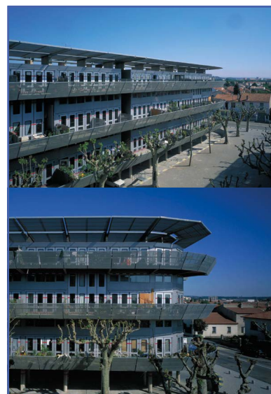
COMPLESSO NEMAUSUS, NÎMES. L'INVOLUCRO ESTERNO È REALIZZATO CON COMPONENTI INDUSTRIALI UTILIZZATI NELL'INDUSTRIA FERROVIARIA.
